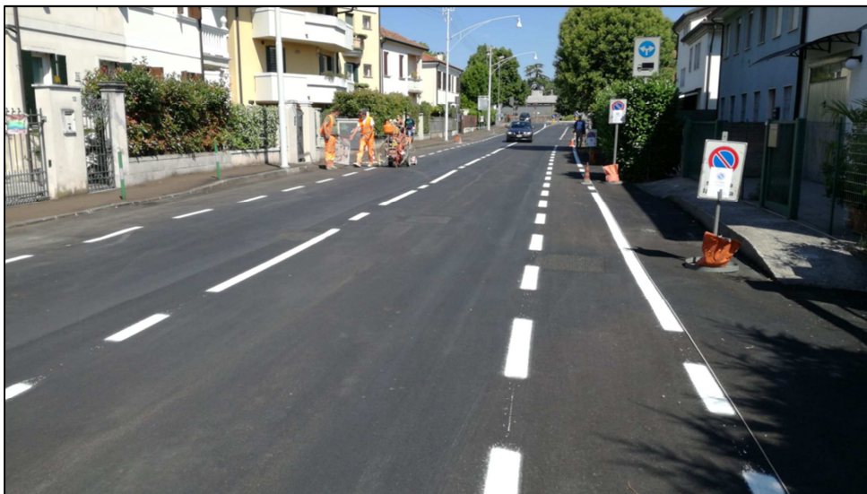
Tracciamento di una corsia ciclabile (Padova)
